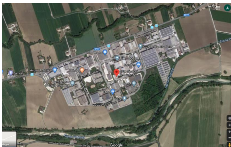
Veduta estrapolata da Google maps della Sede Amministrativa e Direzionale della CPM
